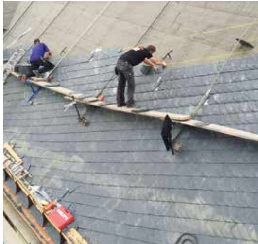
Mit über einer halben Million Schieferplatten wurde das Dach des Unteren Schlosses neu gedeckt.
