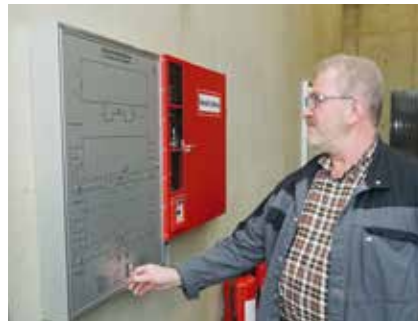
Oberkesselwärter Heinz Zensen überprüft die Brandmeldeanlage der neuen Instandsetzungshalle.
