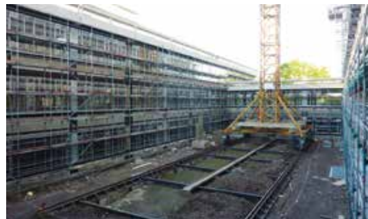
Links: Ein Kran im Innenhof hebt schwere Teile an ihren Platz.
