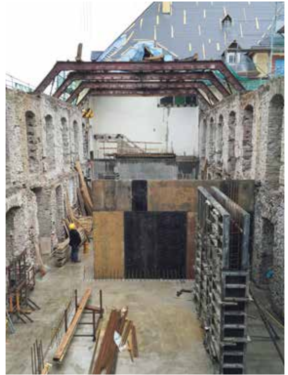
Wegen der Vornutzung als JVA musste der Wittgensteiner Flügel komplett entkernt werden.
