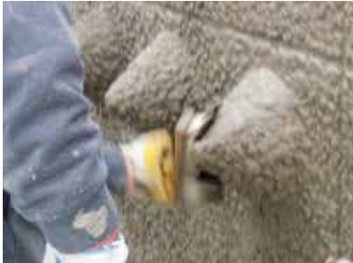
Die Waschbetonplatten der Fassade mussten im Zuge der Sanierung so manchen Arbeitsschritt über sich ergehen lassen. Dazu gehörten das Bohren für neue Befestigungsanker und das Auftragen der Zementschlämme mit einem Quast.
