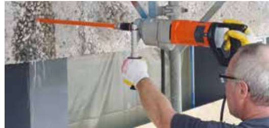
Die Waschbetonplatten der Fassade mussten im Zuge der Sanierung so manchen Arbeitsschritt über sich ergehen lassen. Dazu gehörten das Bohren für neue Befestigungsanker und das Auftragen der Zementschlämme mit einem Quast.
