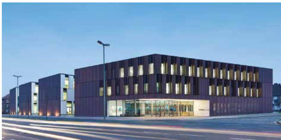
Die grobmaschigen Streckmetall-Elemente aus Kupfer, die am Neubau montiert wurden, prägen die Optik der charakteristischen Fassade des Bottroper Campus-Gebäudes.
