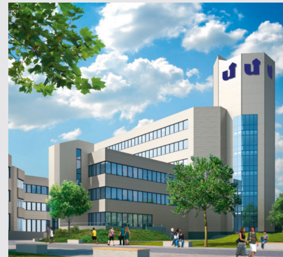
... und nach Fertigstellung
