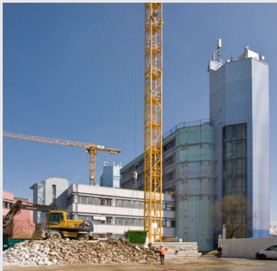
Der Campus während der Modernisierung ...
