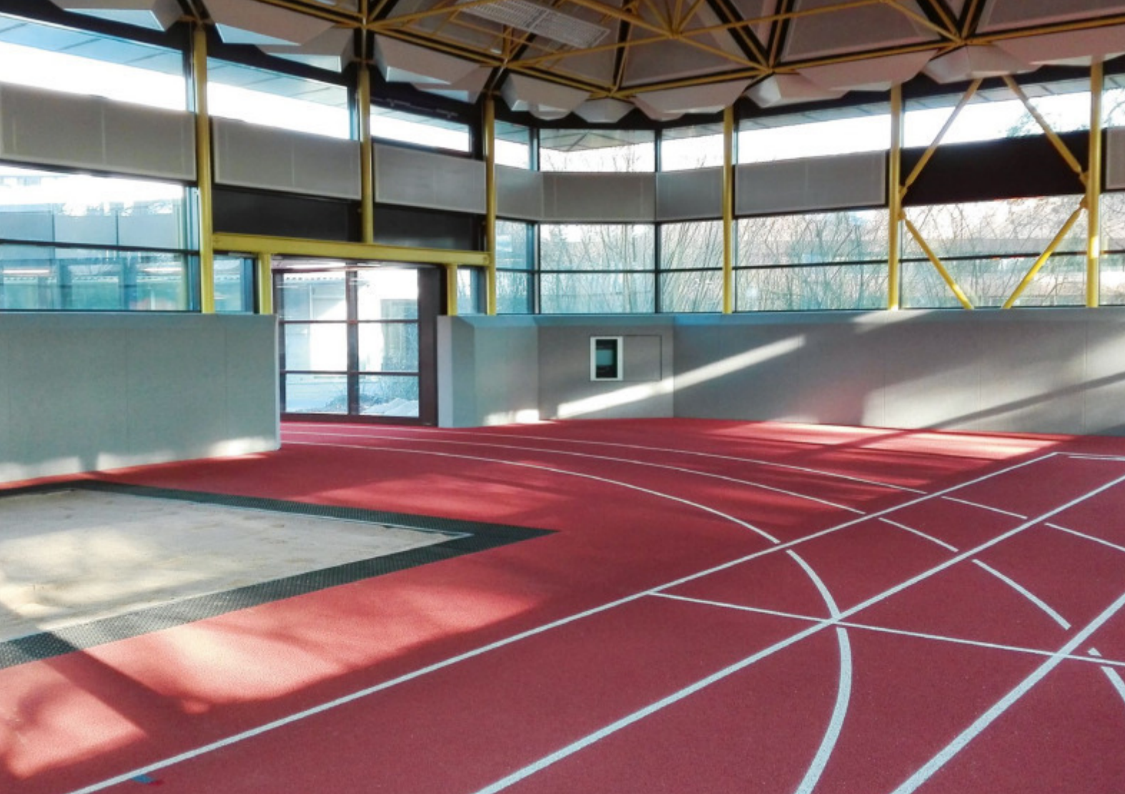
Ein Teil der Laufbahn führt durch die bestehende Halle, der andere Teil außen herum durch einen Tunnel.
