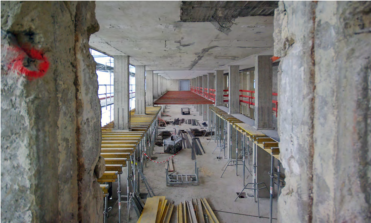
Kernsanierung statt Abriss am Sammelbau Maschinenwesen der Aachener RWTH
