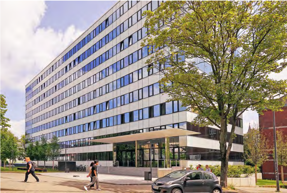
Der Sammelbau Maschinenwesen der RWTH in Aachen
