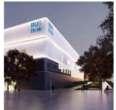
Das Gebäude THINK für die Ruhr-Universität Bochum wird komplett mit BIM digital geplant und gebaut
