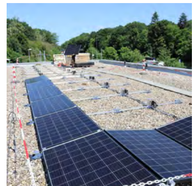
Montage von PV-Modulen auf der Autobahnpolizeiwache in Mönchengladbach
