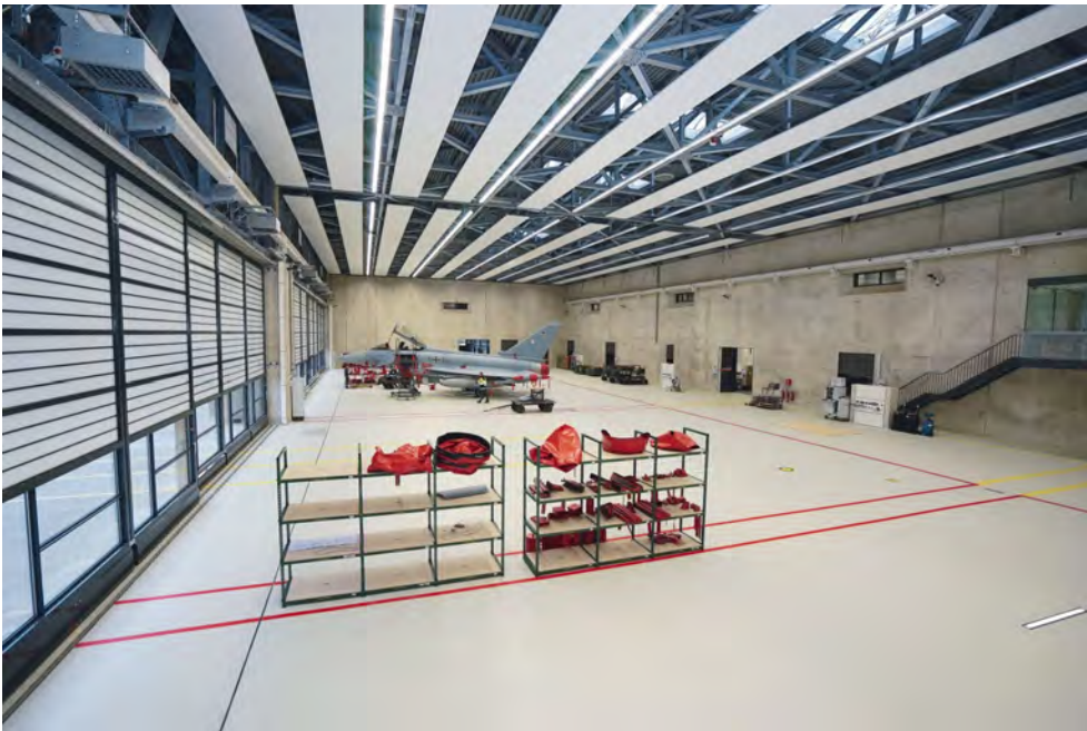
Die Wartungshalle in Nörvenich, in der der BLB NRW für den Bund tätig ist
