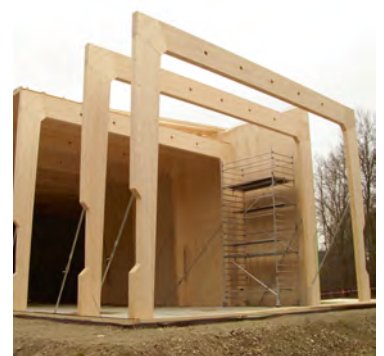
Das Gebäude 16.11 für das Forschungszentrum Jülich beherbergt Magnetresonanzspektrometer und wurde komplett aus nicht magnetisierbarem Holz gebaut
