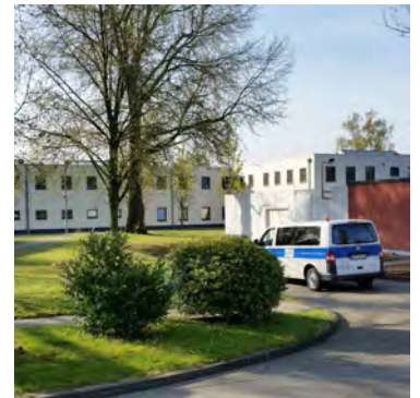
Größe und Energiebedarf der JVA eignen sich besonders für die Pilotierung eines Contracting-Projekts
