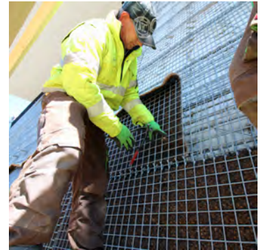
Der BLB NRW arbeitet im Austausch mit seinen Anspruchsgruppen an der optimalen Gestaltung der von ihm betreuten Gebäude
