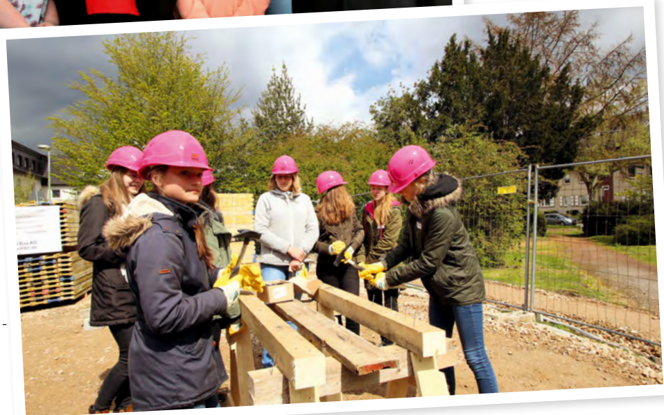
Zentrale Ein spannender Tag auf der Baustelle
